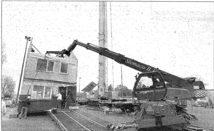
Ballast Nedam bouwt woning binnen 24 uur (foto PR)
